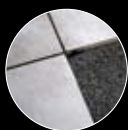
Свободная укладка на гравийную подушку.
