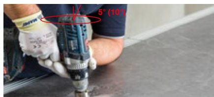
Порядок действий по созданию круглого отверстия
