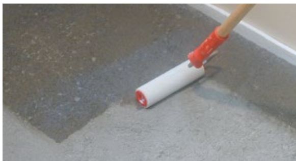
Нанесение PRIMER G
