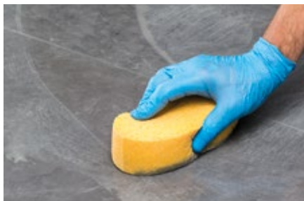
Очистка плитки с помощью пада скотч-брайт и завершение очистки с использованием губки
