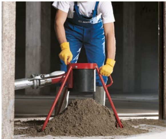
Укладка стяжки с помощью ТОРСЕМ PRONTO
