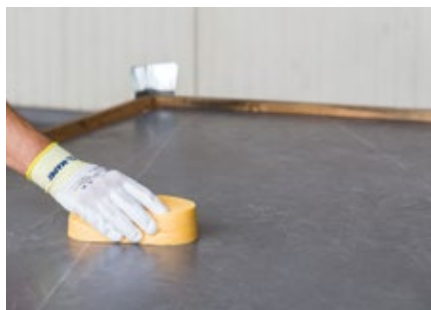
Очистка поверхности плитки
