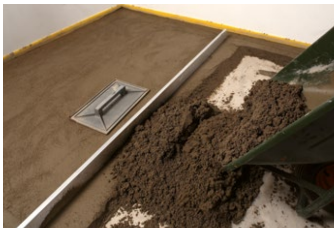
Укладка стяжки на основе ТОРСЕМ PRONTO
