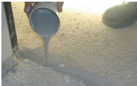
Заливка трещин в основании с помощью EPORIP
