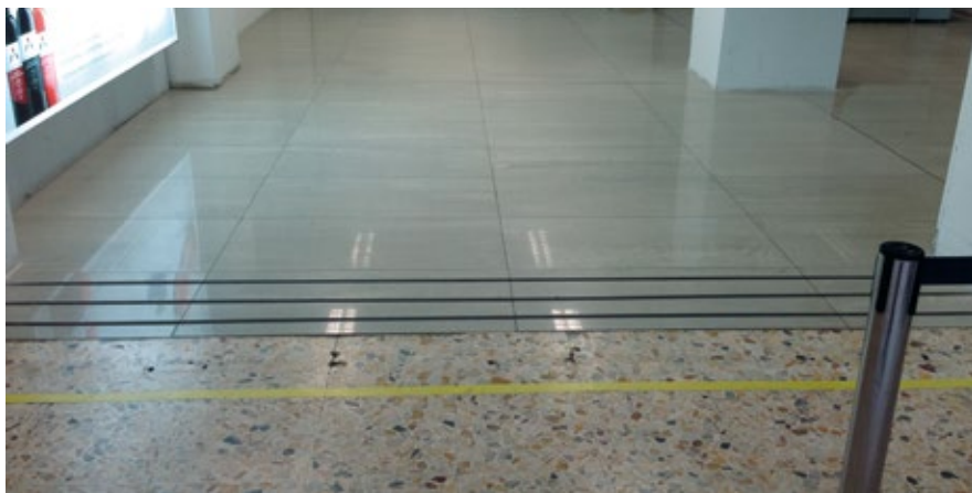
Укладка плитки поверх существующих полов
