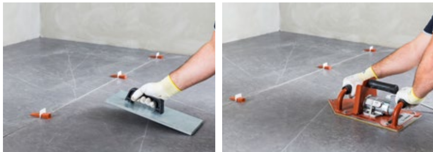
Простукивание плитки вручную или с помощью вибропанели
