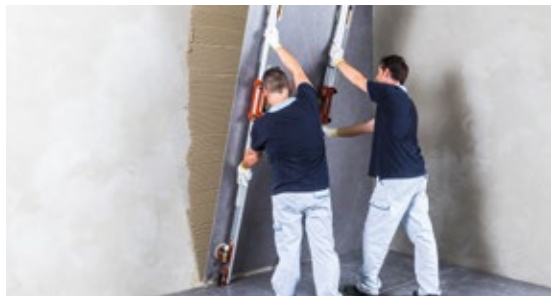
Укладка плитки на стену
