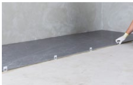
Установка разделителей в требуемое положение
