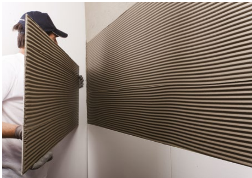
Укладка плитки с применением метода двойного нанесения
