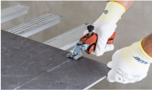
Разламывание плитки с помощью щипцов для надлома
