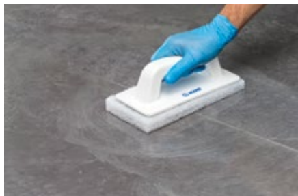
Очистка плитки с помощью пада скотч-брайт и завершение очистки с использованием губки
